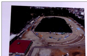
2019年6月撮影 (競技場フィールド下地工事、管理棟内装工事、本部棟スタンド工事)
