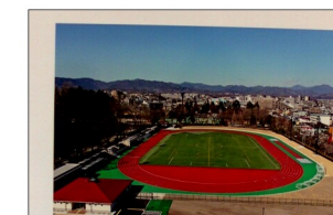
2020年2月撮影 (施工完了)
