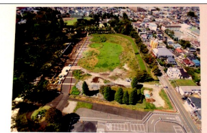
2018年10月撮影 (施工前)
