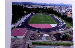
2019年9月撮影 (競技場フィールド人工芝張り、管理棟・本部棟完了)
