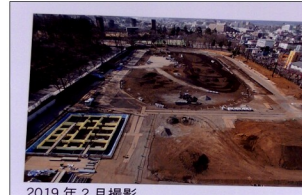
2019年2月撮影 (競技場基礎整正、管理棟基礎工事、本部棟躯体工事)
